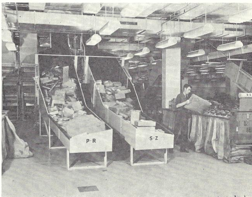
Fig. 8. — Parcel Storage Hoppers, Suburban.
